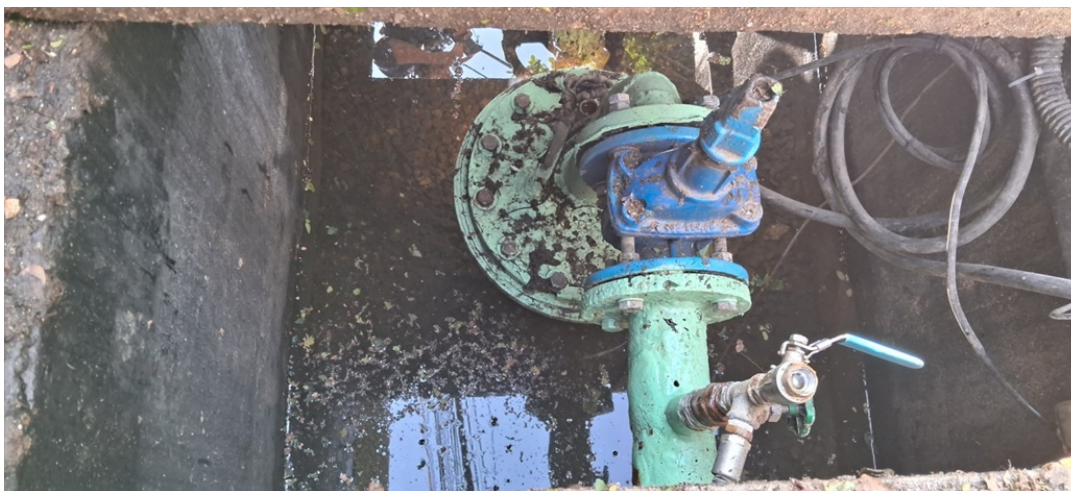
Foto 2 - Vista do corpo externo do CMB e tubulação de recalque dotada de válvula de gaveta. Nota-se necessidade de limpeza e drenagem da água pluvial acumulada no fundo.
