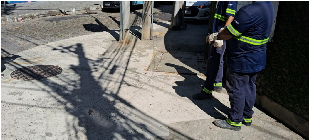
Foto 1 - Vista geral da estação. Nota-se necessidade de manutenção na pintura da sinalização viária ao redor do tampão.
